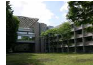
美術学部総合工房棟 Factory Complex, Faculty of Fine Arts
